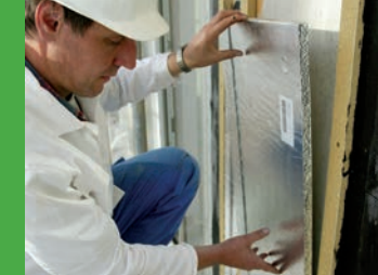
Montage der Platten
